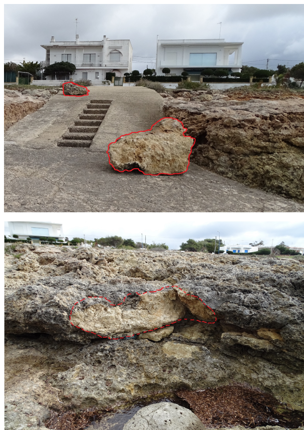
Figura 3: Torre Suda; in alto, sono evidenziati il blocco staccato dalla massa rocciosa (in primo piano) e un suo frammento (sullo sfondo); in basso, la nicchia di distacco ubicata a circa 7 m dal blocco.
