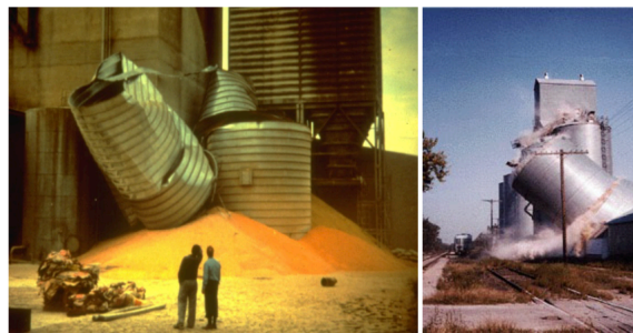
Figura 2: Silos crollati per un'imprevisto sbilanciamento della pressione interna sulle pareti rispetto al fondo. I crolli sono in parte dovuti alla legge di Janssen (spiegata nel testo) che complica la progettazione, sia alle grandi fluttuazioni interne delle forze tra i grani che implicano deviazioni imprevedibili da questa stessa legge.
